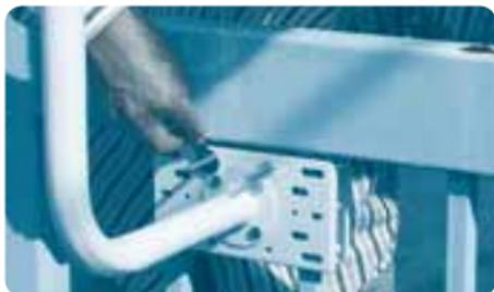
ベランダの手すりを挟むように、**[ベランダ取付金具]**のベースを**[スパナ]**で固定します。
