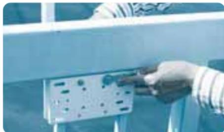
**[衛星放送用アンテナ]**を取り付ける場所を決め、**[ベランダ取付金具]**の固定箇所を確認します。
